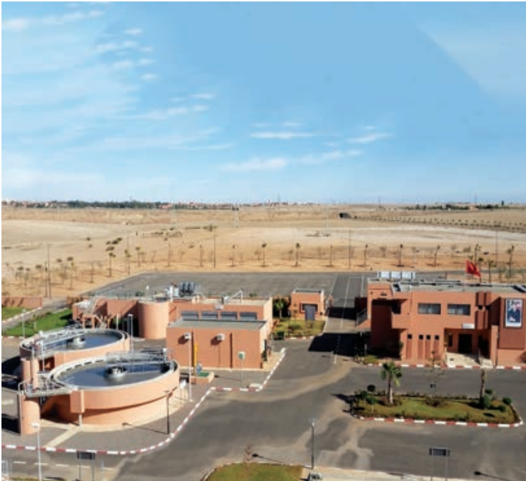
Station d'épuration de BENGUERIR
