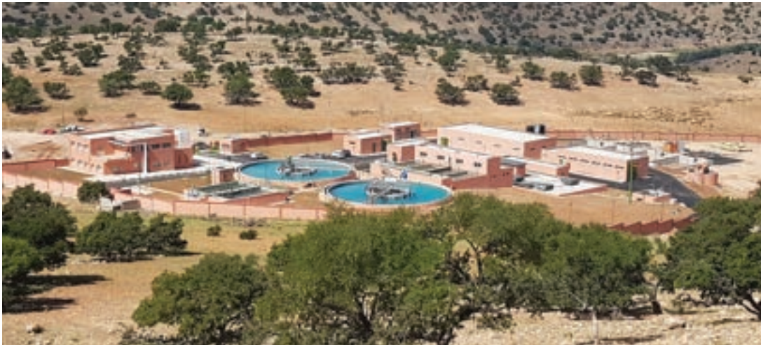
AEP de la ville d'Essaouira ( Capacité de 250 l/s )
